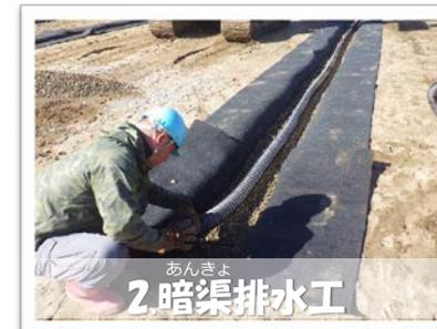
▲ 水はけが良くなるよう、全面に暗渠管を敷設します。
