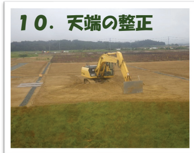
▲ クロマツの苗木を植樹する前に、天端の攪拌（深さ1m）を行い、均平に整正します。
