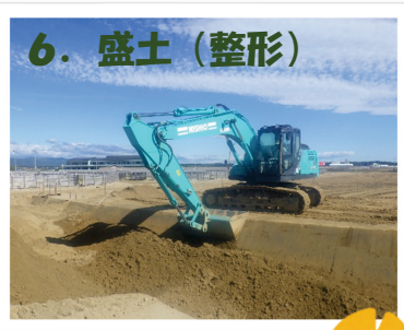
▲ 法面の整形をします。
