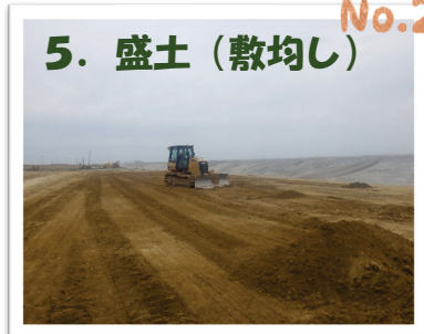
▲ 搬入した盛土材を敷均します。
