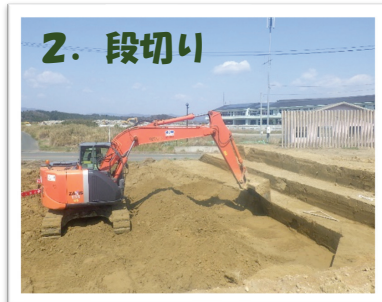
▲ 既設盛土との密着を図るため、段切りをします。
