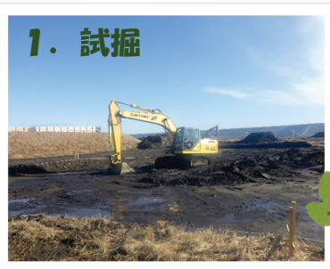
▲ 住宅跡地に異物が無いか確認します。
