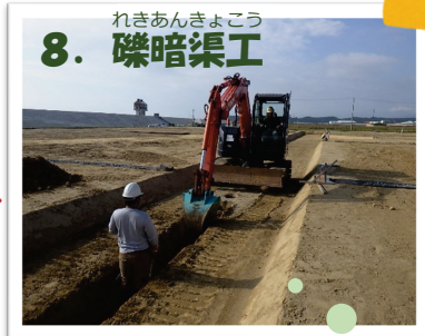
▲ 盛土部の排水処理のため、暗渠を設置します。
