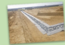
▲ 盛土部の排水処理のため、暗渠を設置します。
