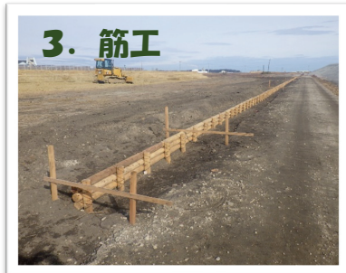
▲ 土砂流出防止のために、丸太柵を設置します。
