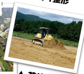
▲ 基盤整地状況
