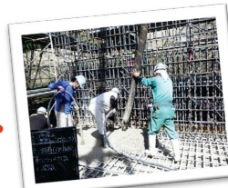
▲ コンクリート打設
