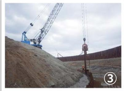
③ 掘削後、防潮堤本体の本設鋼矢板を打設します。
