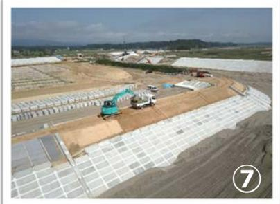
⑦・⑧ 盛土が完了した後に被覆工、天端被覆工を施します。
