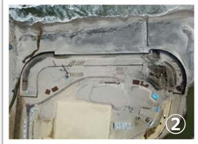
② 掘削中に想定以上の湧水、出水で掘削不可能となり、背面部に鋼矢板を増設しました。
