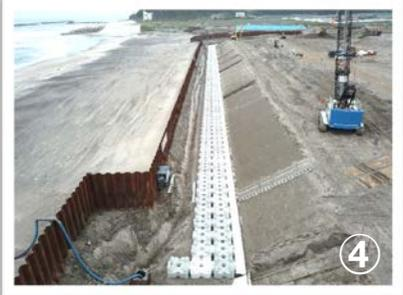
④・⑤ 基礎、根固めブロックを設置後、堤防被覆工へ移ります。
