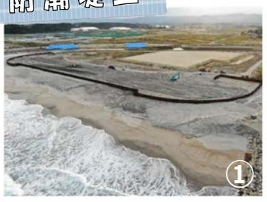
① 防潮堤掘削での止水目的の仮設鋼矢板を設置します。
