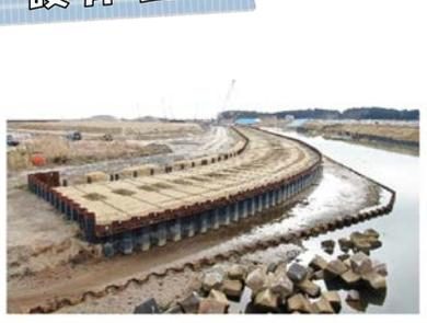
1. 前田川からの浸食を防止するため、鋼矢板 (ハット10H) L=9.5m 170枚を打設。
