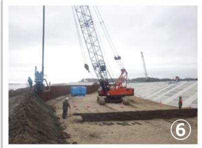
⑥ 仮設鋼矢板②を引抜き、堤体盛土を開始します。
