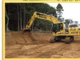
▲ ICT施工(情報化施工) 掘削
