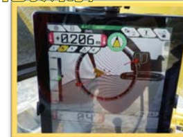
▲ ICT施工(情報化施工) 路体盛土
