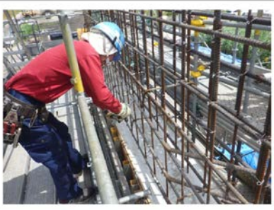
▲ 橋台の骨格となる鉄筋を 組み立てる作業
