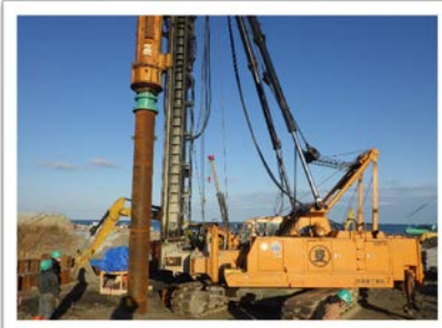
▲ 橋を支える基礎として 鋼製の杭を地中に打ち込む作業
