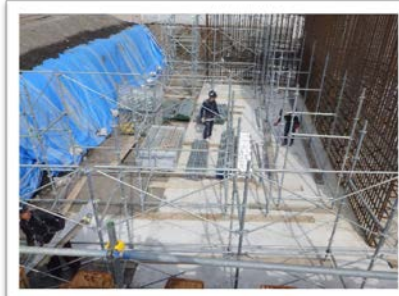
▲ 足場を組み立てる作業
