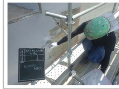
▲ コンクリート表面を塗装剤で被覆し、 コンクリートの劣化を防止する作業
