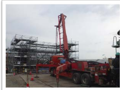
▲ 4~6を繰り返す。一度にすべてのコンクリートを打ち込みできないため、 いくつかのブロックに分けて施工を行う。
