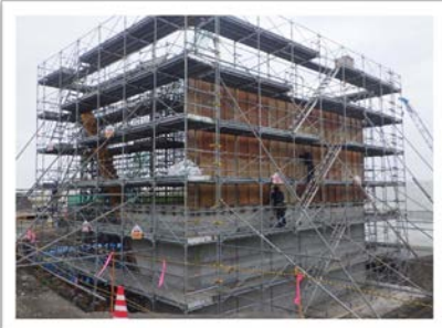
▲ コンクリートを流し込むための 橋台の型を組み立てる作業
