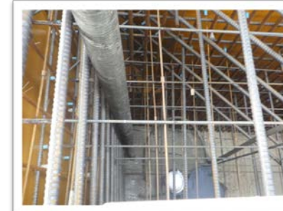
▲ 4~6を繰り返す。一度にすべてのコンクリートを打ち込みできないため、 いくつかのブロックに分けて施工を行う。
